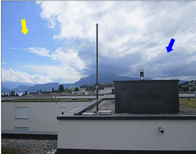
Bild 1: Die Doublet-Inverted-V Antenne von HB9ALH, Isolatoren und Antennendrähte (gelber & blauer Pfeil) sind kaum sichtbar
