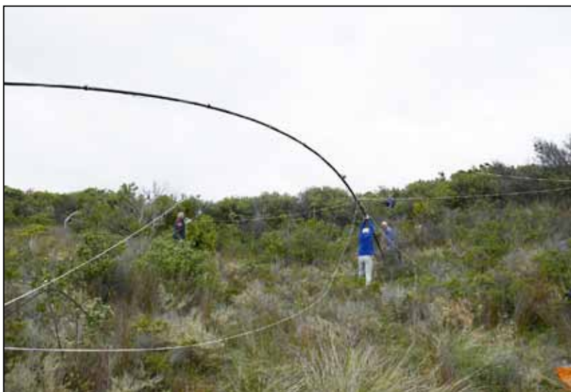
Immer eine Herausforderung: Aufbau der 160m Vertikalantenne
