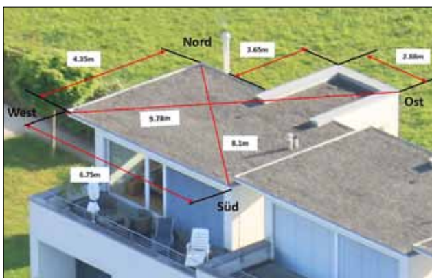
Flachdach-Masse und Ausrichtung
