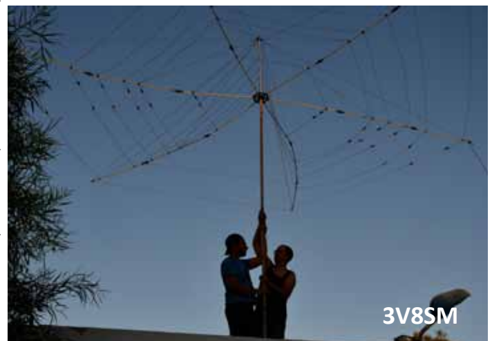
Ludo und Ali beim Aufbau des Drahtbeams
