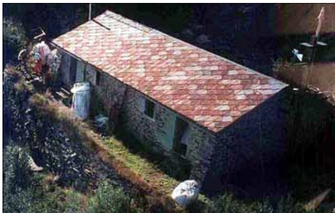
Ehemalige Militär-Baracke "Tamaro"
