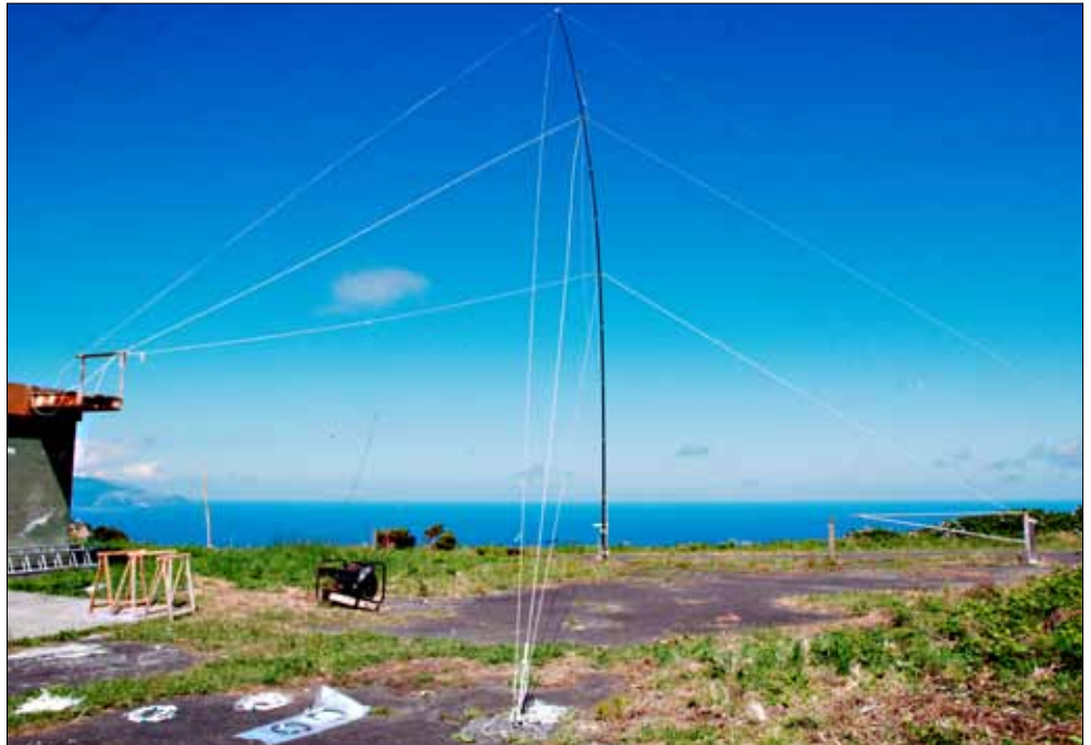
CR2V: Die Delta-Loop für 40 Meter; links der Shack - eine ehemalige Telecom-Relaisstation
