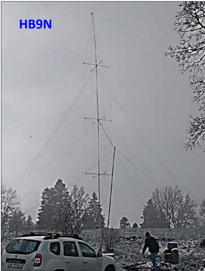
Antenne verticale de 26m de haut pour 160 et 80m
