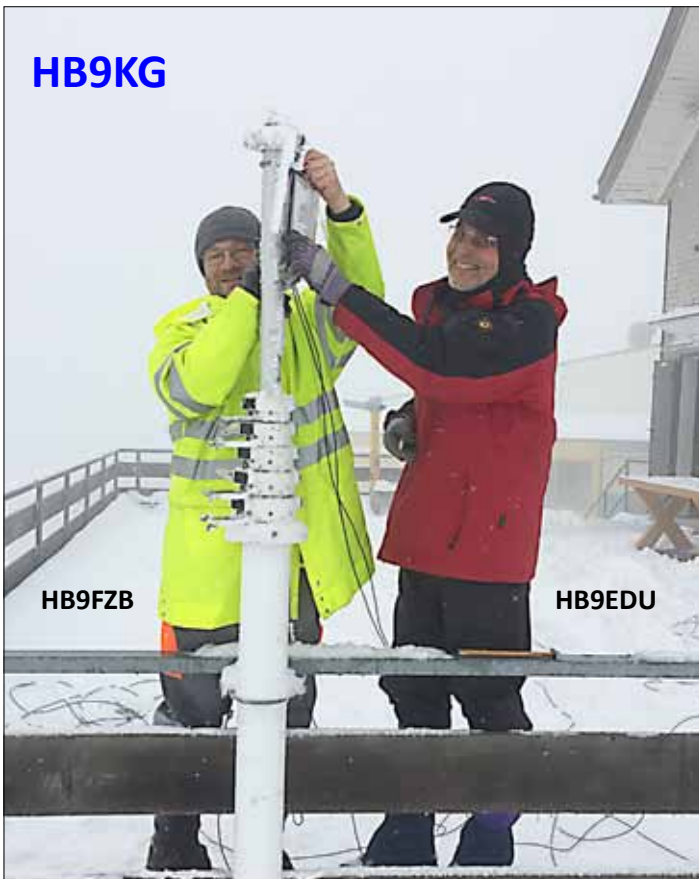
Antenne verticale de 26m de haut pour 160 et 80m
