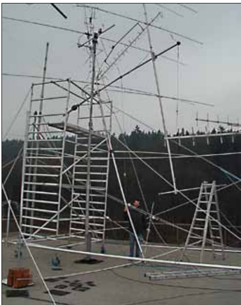
Sturmschäden infolge "Lothar"
