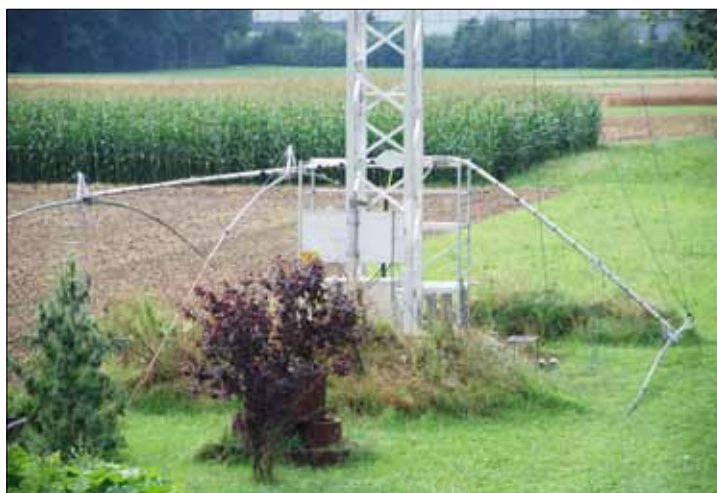
Risultato di una catena strappata
