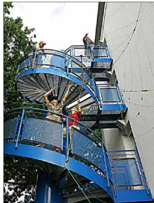
Hisser l'antenne complètement montée sur 3 étages par l'extérieur d'un escalier en colimaçon, un vrai travail d'artistes !
