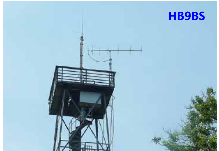
HB9BS: 8 El. Yagi auf dem 28m hohen Gempenturm SO
