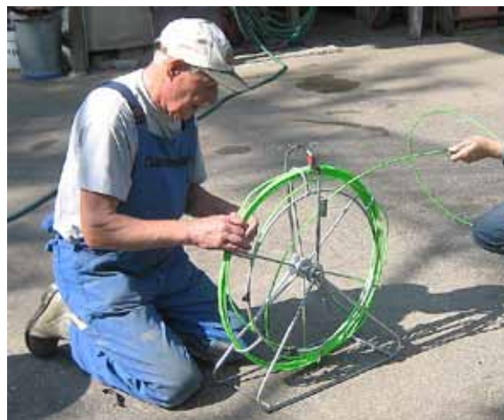
2014: Walti an der Vorbereitung des schwierigen Einzugs für das 50 m lange Koaxialkabel RG213 in das PVC-Rohr von der Klubstation bis zum Schopf neben dem Kinderspielplatz des Tössrain
