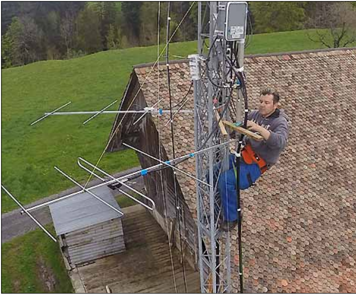
HB9RF: Frédéric HB9TTY beim Antennenbau auf der Seebodenalp (SZ)
