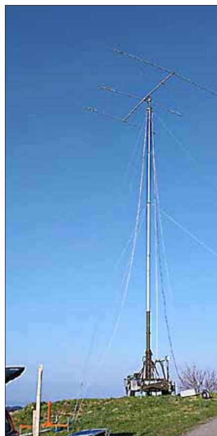
Fahrbahner Teleskop-Beam bei HB9ØIARU
