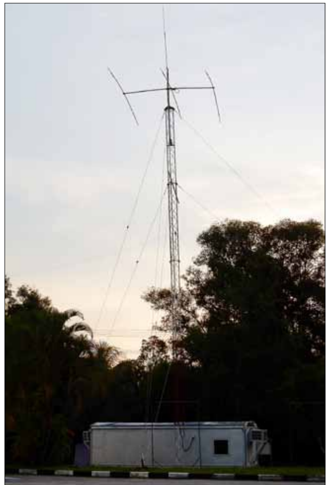
Shack-Container mit 3el. Beam auf 12m
