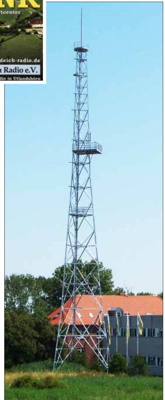
Dieser Funkturm konnte erhalten werden
