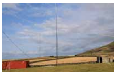
40m Delta-Loop, rechts das Generatorhäuschen, links die zwei Materialcontainer
