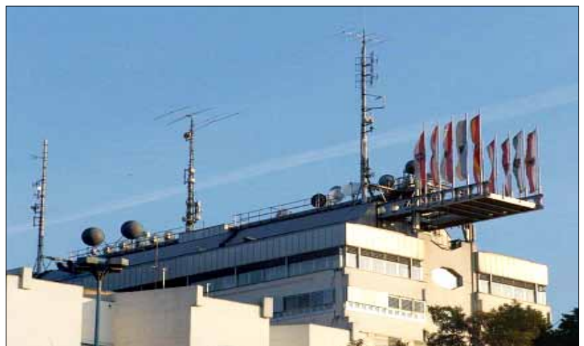
Auch Amateurfunk-Masten am Königberg, dem ORF Zentrum (nr Wien): Die Station OE1XRW im obersten Stock des ORF-Zentrums nützt für den Verkehr auf 40 und 80 m eine kaum sichtbare Drahtantenne, die zwischen den beiden äusseren Masten hängt. Der Beam ganz oben auf dem mittleren Mast wird für DX-Verkehr auf den höheren Kurzwellenbändern benutzt. Die Clubstation OE1XRW bildet einen Teil der ORF-Sportvereinigung.
