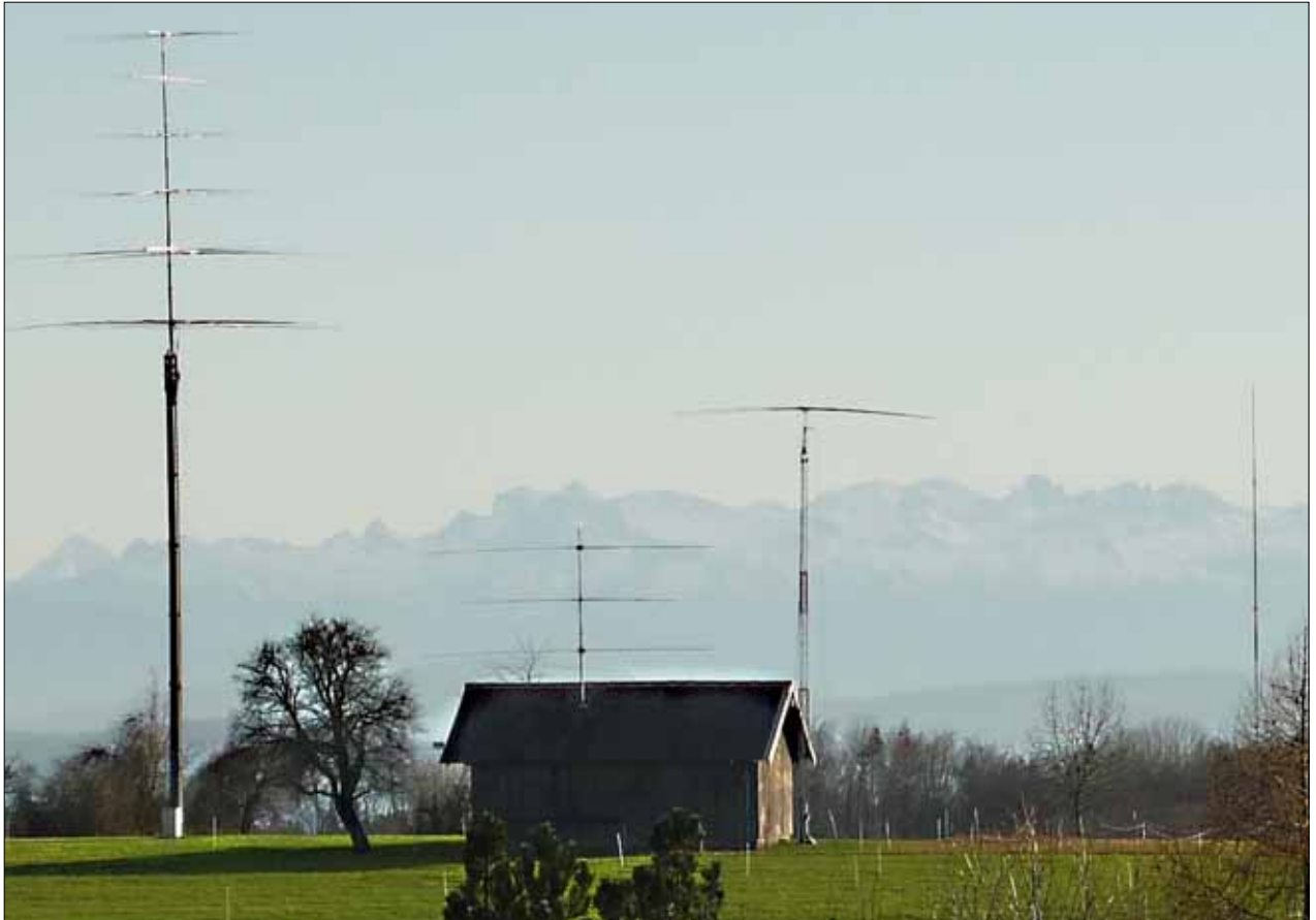
HB9CA - die legendäre "Letzi" sorgt mit dem 6 el.-Monobander für ein mächtiges Signal auf 20 m
