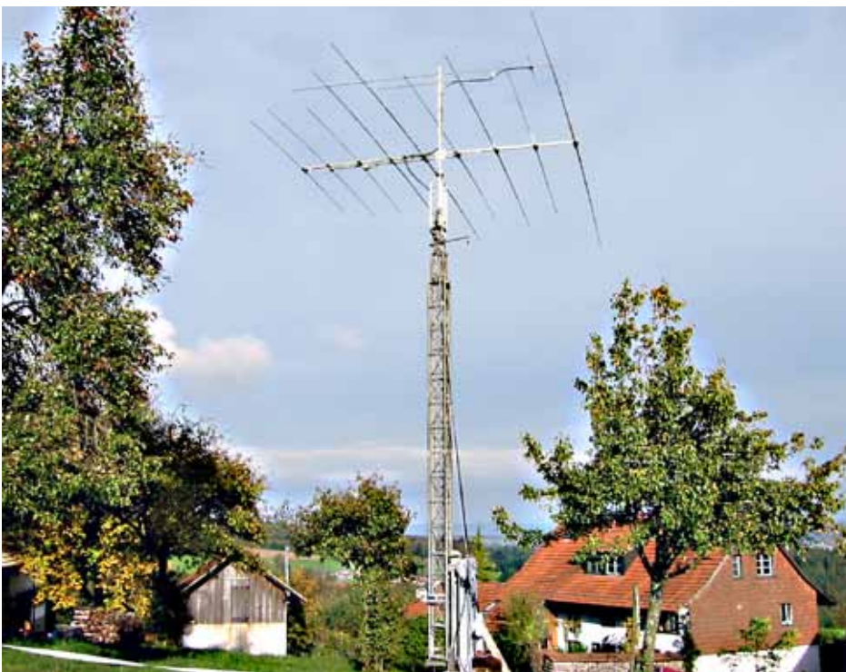
NACHHER - Alles in neuen Glanz: kipprbarer Teleskop-Tower mit 5-Band KW-Beam und 2 m-Beam
