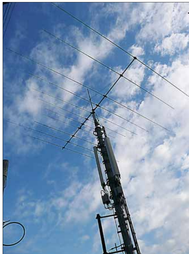
hy-gain TH-11DX KW-Beam auf dem VHS-Hochhaus: 10-20m, max. Gain 9,2 dBi, Boom 7.3m, 2 kW, 40kg [Foto: HB9AUR]
