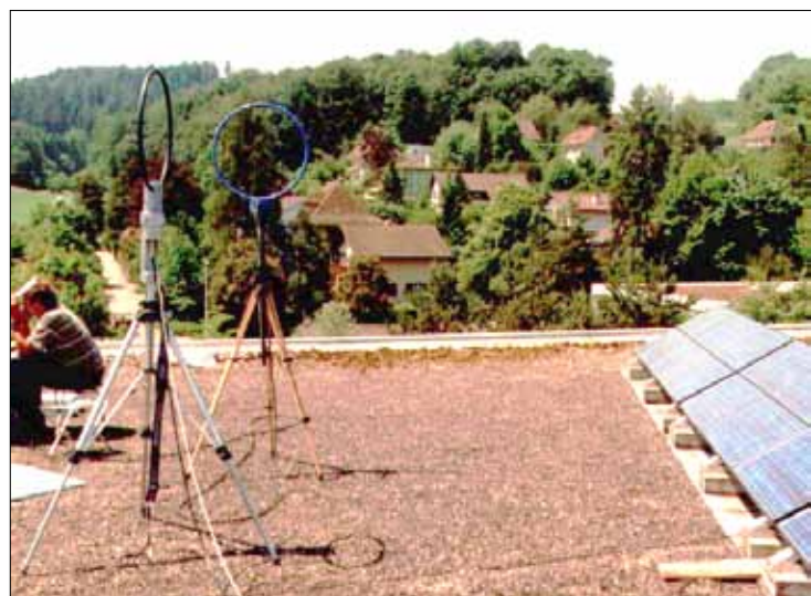
Bild 2: Messung der abgestrahlten Feldstärke im Abstand von 3m bei einer 3 kW-Photovoltaik-Anlage in Burgdorf (27.05.1999)
