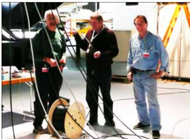
Kari HB9BRG, Gregor HB9CRU und Urs HB9MYH beim Kabelverlegen [Foto: HB9AUR]
