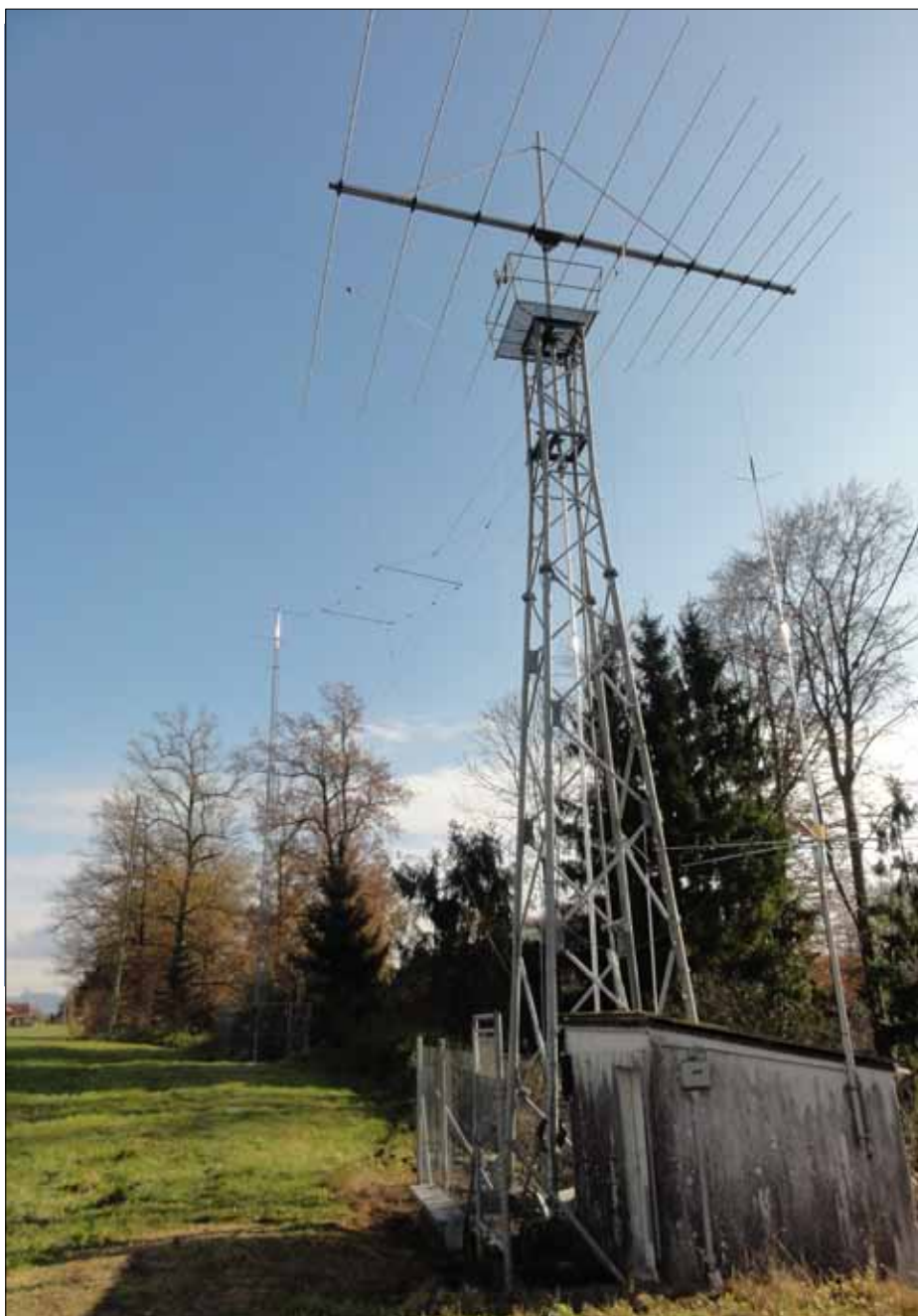
Bild 1: Die Logper-Antenne von HB9XQ in Neueneegg BE
