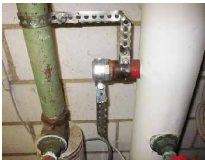
Foto 3: Erdung mit max. 2 \Omega (!) Übergangswiderstand
