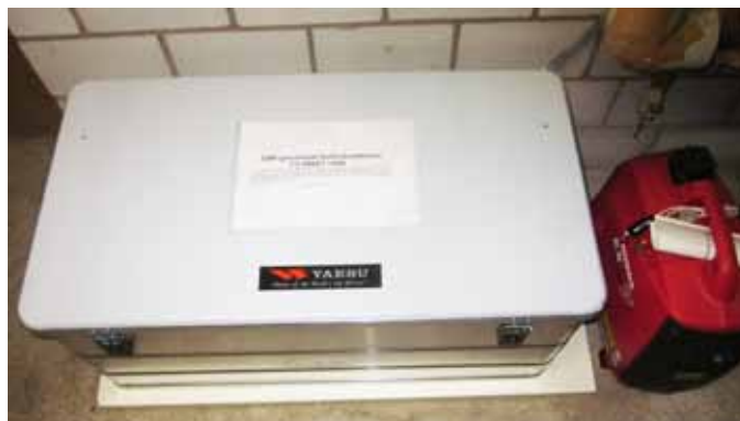
Foto 1: Alu-Box mit Stromgenerator
