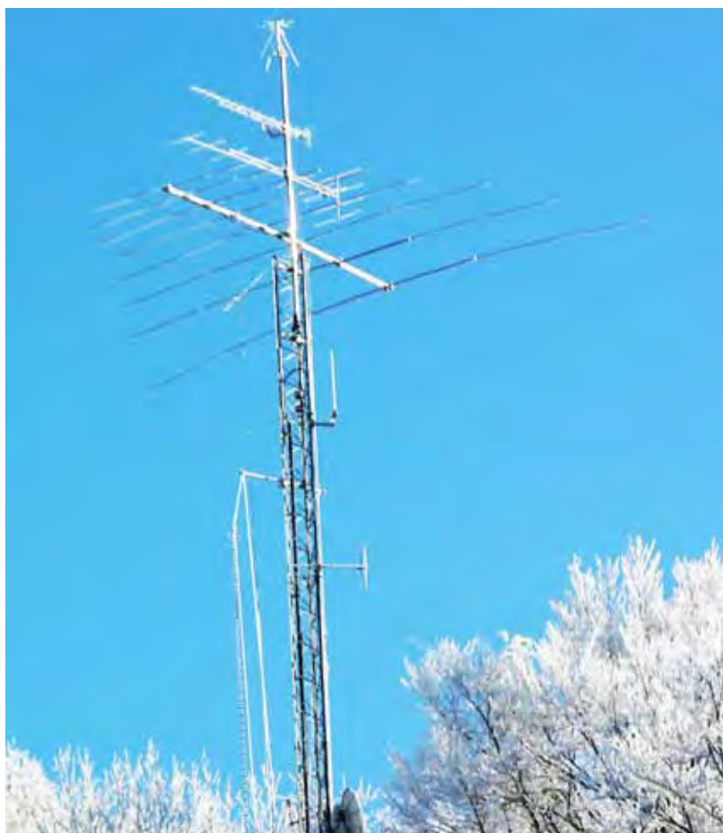
Radiohill Girenbad ob Turbenthal ZH mit Titanex LP-8 auf 30 m Letrona- Stahlgittermast (www.radiohill.ch) (Foto: HB3YIF)
