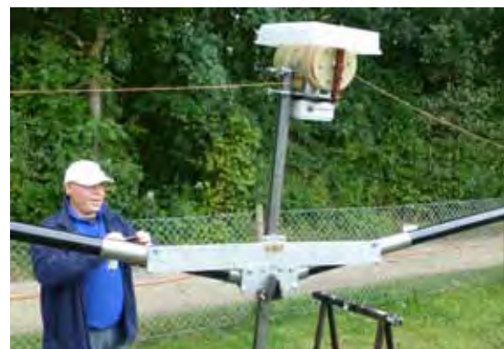
HB9BE: Giovanni HB9EKH übrprüft den massiven Abspann-Mechanismus des variablen Dipols
