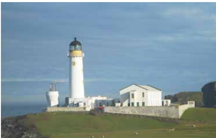
Lighthouse mit Schrägdach-Nebengebäude (=Shack)
