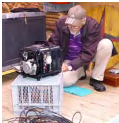
HB9BE: Generatorwart Hans, HE9BCW im vollen Einsatz
