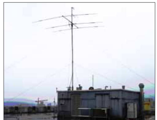
Die Clubstation HB9ZZ der ETHZ auf dem Dach des ETZ-Gebäudes an der Gloriamstrasse 35 in Zürich
