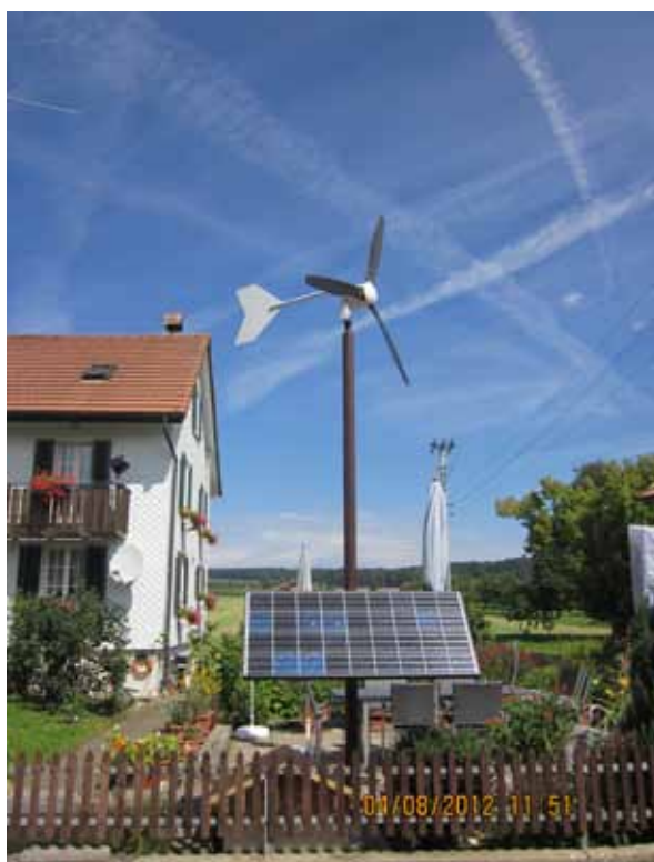
Bild 1 / foto 1: Windgenerator und Solarpanel von HB9TZR
