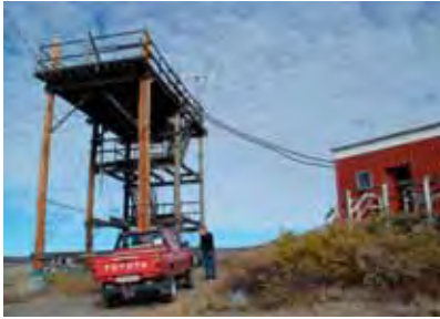
La tour d'antennes et le shack OX2A
