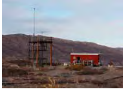
La tour d'antennes et le shack OX2A
