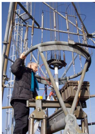
HB9DBC en train de connecter le feeder à la boîte d'accord télécommandée
