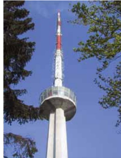
Bild 2: 50 Meter über Grund in der Kanzel der Mehrzweckanlage Uetliberg befinden sich Bake und Antennen.
