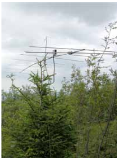
Am Abhang des Pilatus ist die Antenne von HB9THJ Richtung Norden gerichtet
