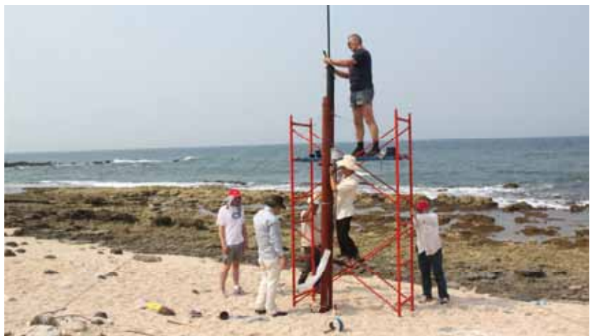
Aufbau der Vertikalantenne für 160 m (Alle Bilder: 3W6C-Team)
