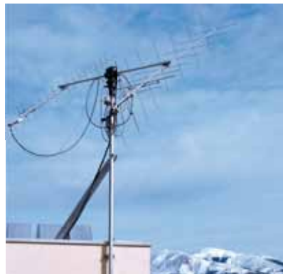
Antenne der Tlsat- Bodenstation
