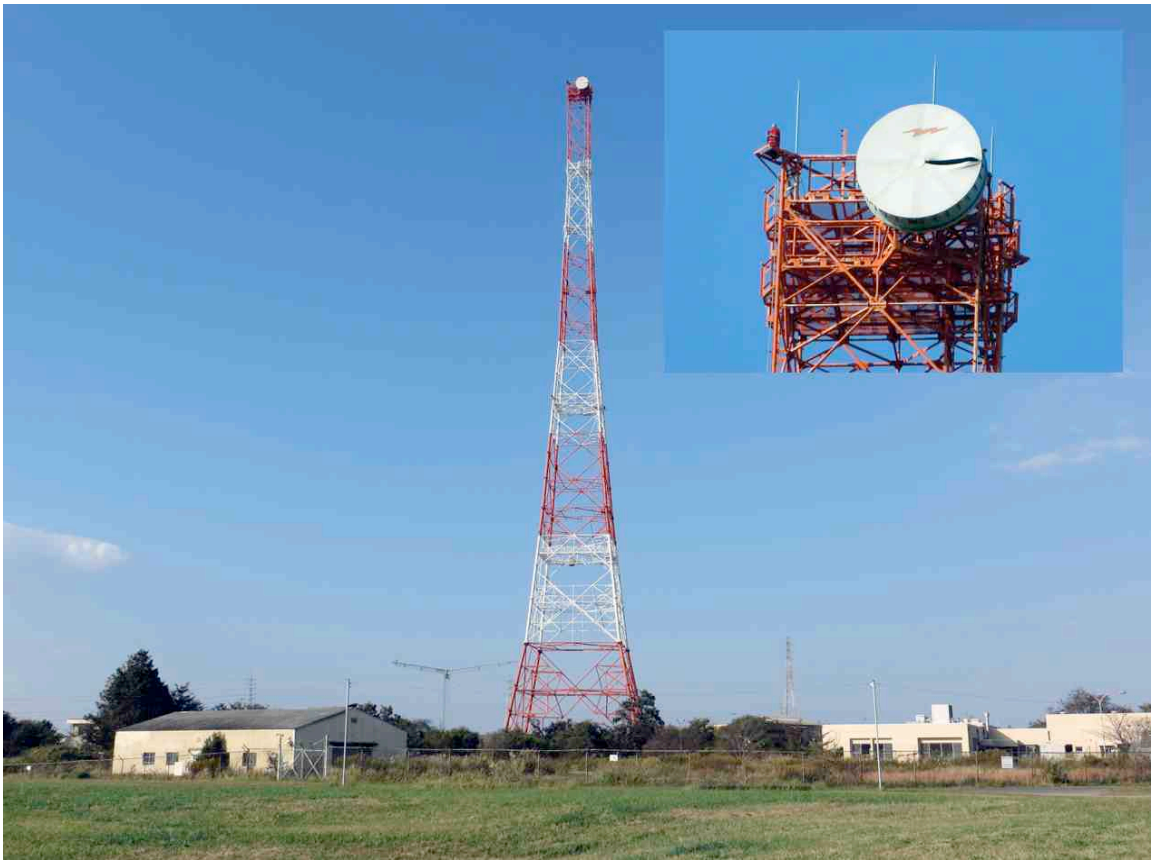
偉容を誇るマイクロ波タワー。頂上部南向きのパラボラカバーは裂けて破損しており、時の流れを感じる
