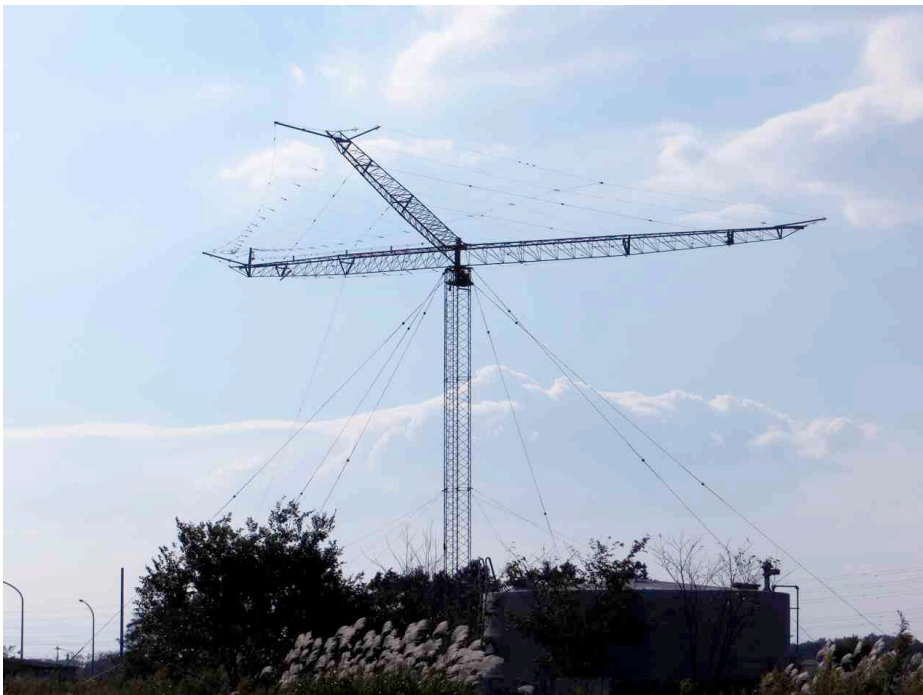
ログペリオディックダイポールアンテナ(LPDA: Log-Periodic Dipole antenna Array)
