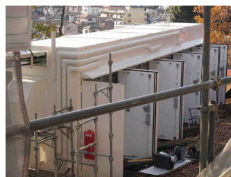
↑建造中の局舎。奥には蓄電池設備も併設されています
